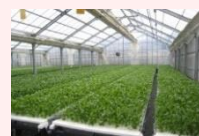
農業生産施設(水耕栽培ハウス)
